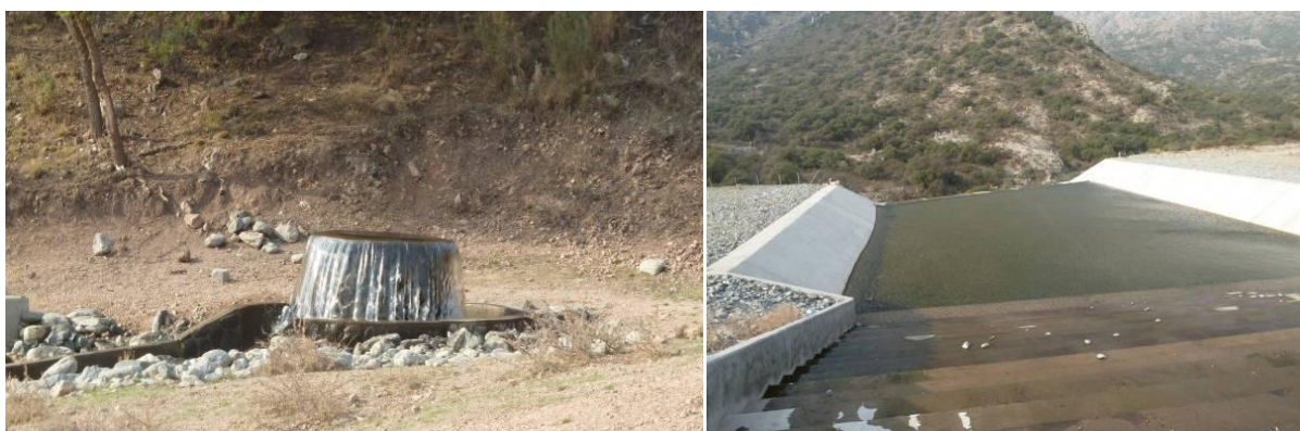
Figura 38. Dique La Sepultura en el Parque Presidente perón. Vista panorámica (arriba). Obra de ingreso de caudal al lago (abajo, izquierda) y Obra de Vertedero de rebose (abajo, derecha).
